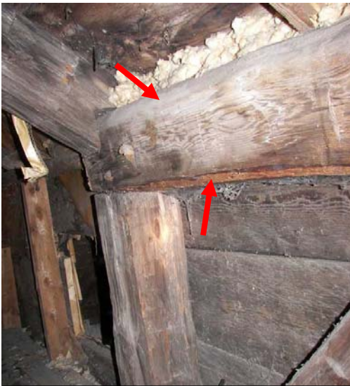
Photo 2: Vue du grenier de la maison Michel LeBlanc. La flache d'une des poutres est indiquée par des flèches rouges.
