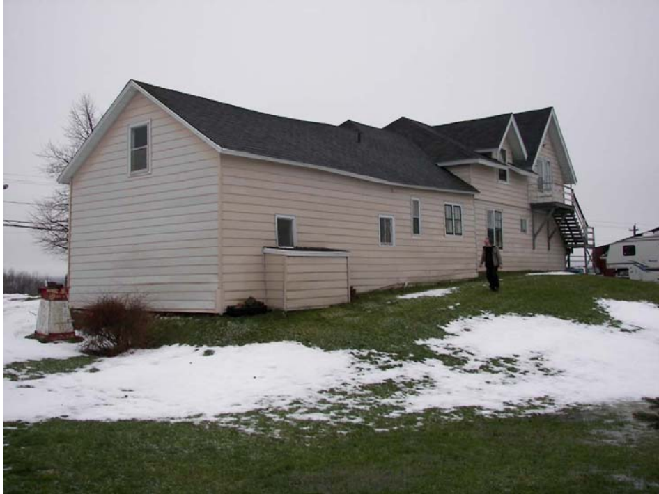
Photo 3 : Vue arrière de la maison Pierre Bourgeois. La partie allongée sur la gauche constitue la «shed».
