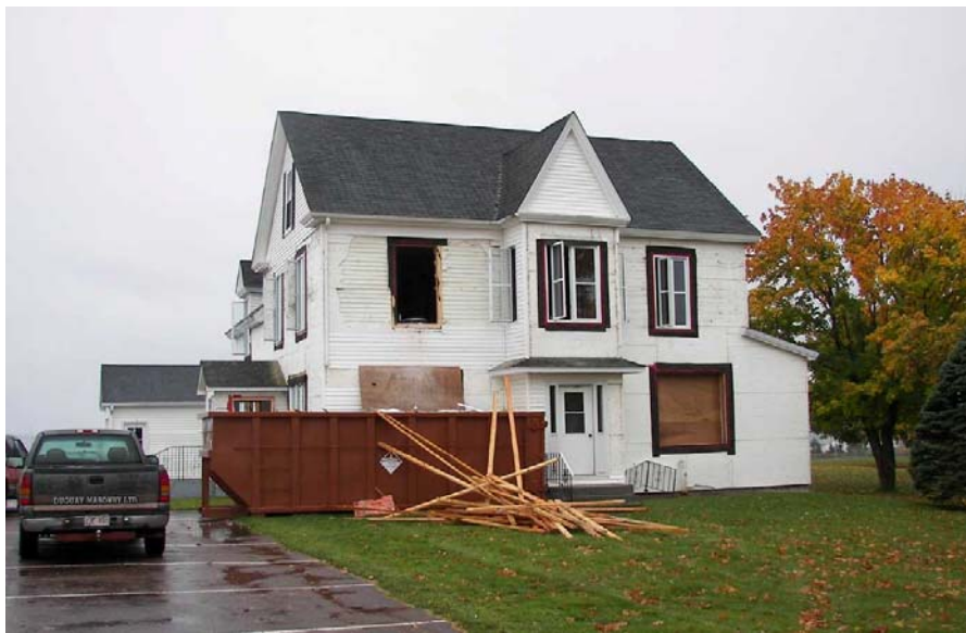
Photo 6 : Le presbytère de Grande Digue durant la première phase de démolition en décembre 2006. (photo : Bernard LeBlanc)
